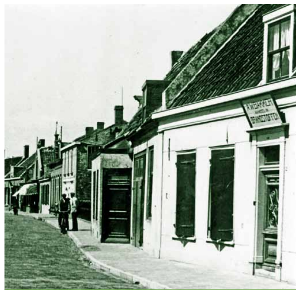
Het Tolhuisje had een soort uitbouw aan de straatkant. Hier op een oude foto nog goed te zien
