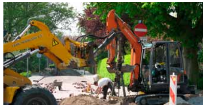
De gebroeders Moerland aan het werk in de Oude Waterlaan. In deze omgeving is ook het waterafvoer verbeterd.
