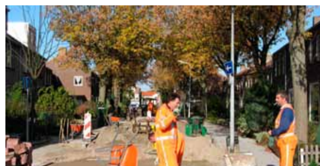
De firma Jac. Ton uit Serooskerke leverde goed werk af in de Hudsonstraat.
