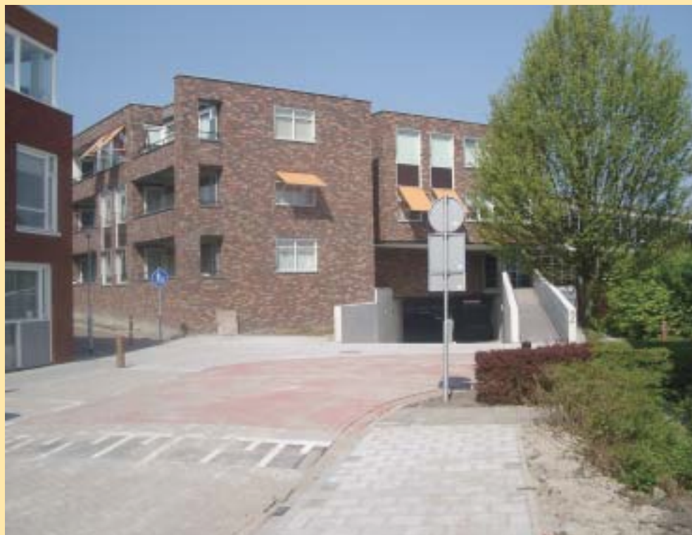
• Achter Nieuw Bachten Poorte ligt de straat er weer goed bij.
