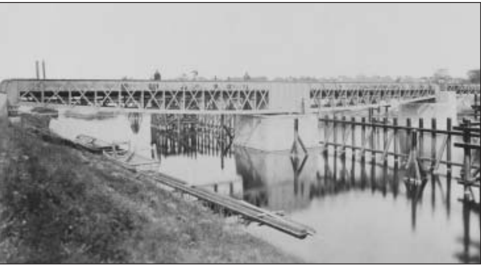
• Foto-impressies van de bouw van de brug over het kanaal.
