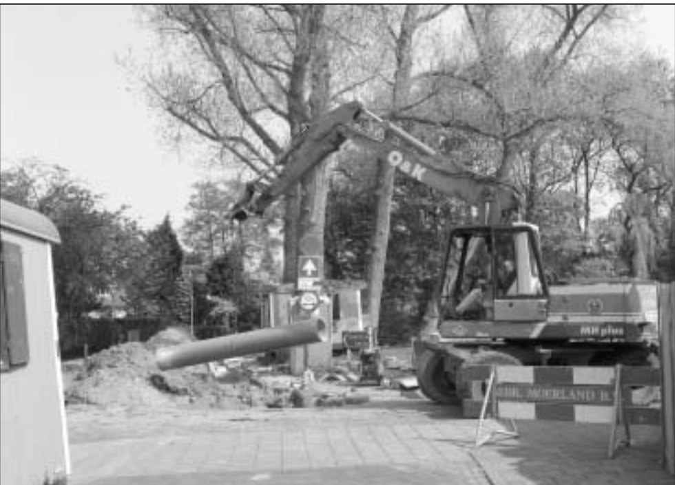
• In diverse straten in Souburg werd de riolering vernieuwd. De komende tijd zal in elk geval extra geld uitgegeven moet worden aan de over het algemeen penibele toestand van de riolering en het onderhoud van de groenvoorziening.
