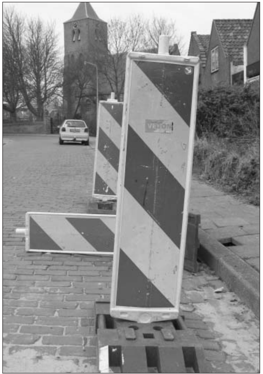
• Er staan al een paar weken pionnen ter hoogte van huisnummer 15. Aan de stoep is duidelijk te zien dat er flink wat zand van onder de tegel is gespoeld.
