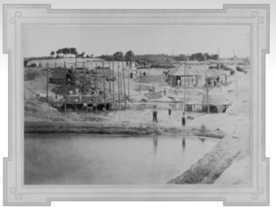
De brug in aanbouw 1869
