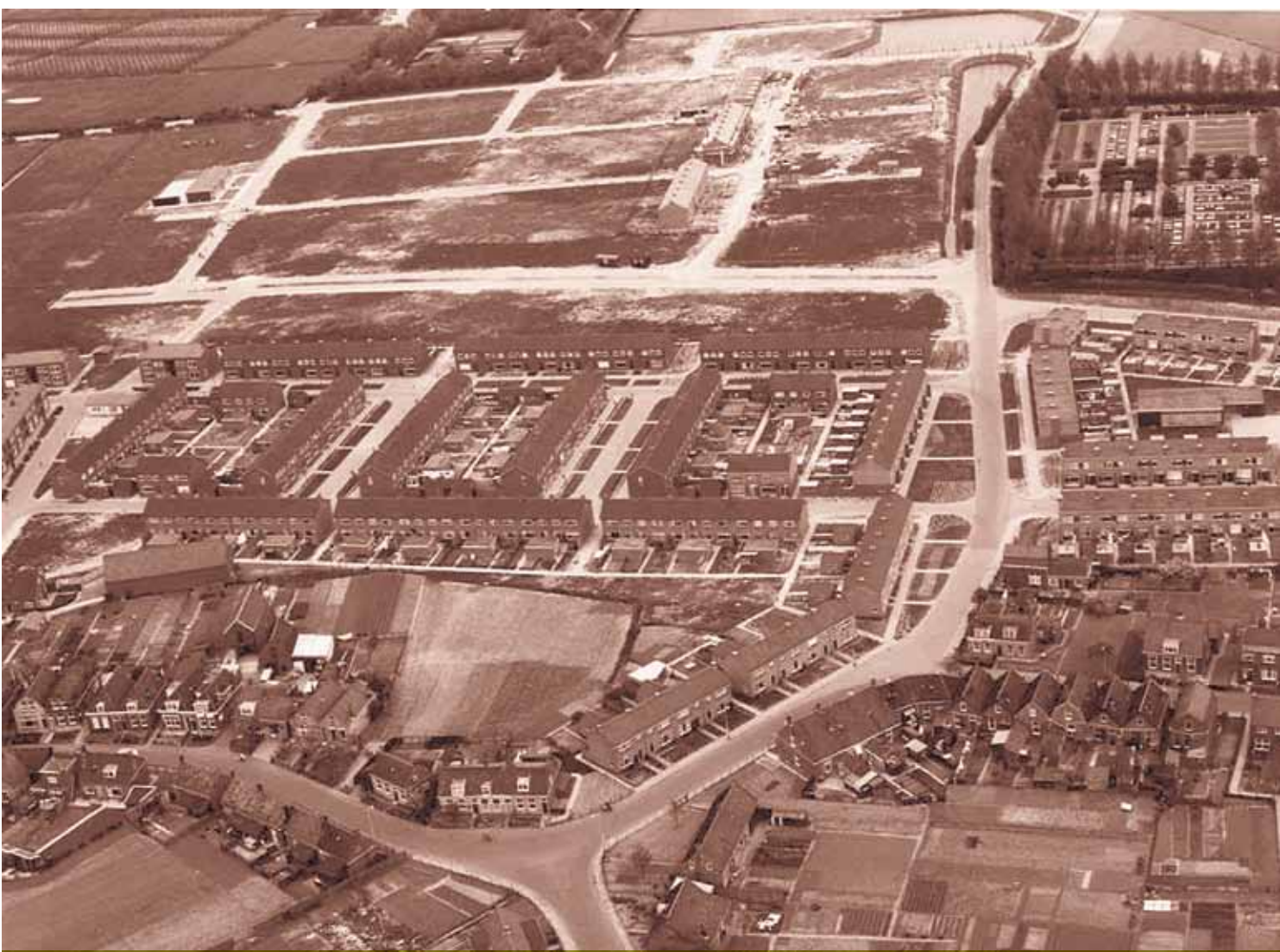
In de jaren zestig en zeventig van de vorige eeuw werd er veel gebouwd in Souburg. Op de foto uit negentienhonderd vierenzestig ziet u de bouw van de eerste woningen aan de oostzijde van de nieuwe Burgemeester Stermerdinglaan.
