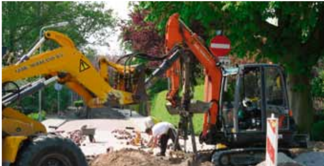
De gebroeders Moerland een paar jaar geleden aan het werk in de Oude Waterlaan. In deze omgeving is ook het waterafvoer verbeterd. De straat ligt er nog steeds goed bij.
